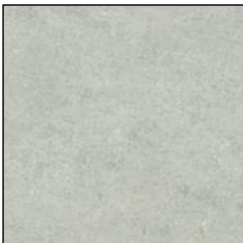
▼トイレ/洗面室 床
